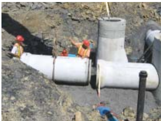
Réseau d'égout sanitaire avec composantes certifiées qui subira les essais d'étanchéité et inspections télévisées.
