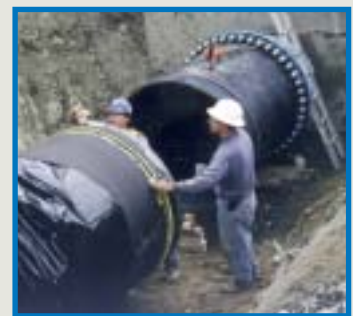
Conduite de 1 350 mm installée avec gaine de polyéthylène.
