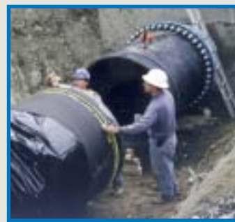
Conduite de 1 350 mm installée avec gaine de polyéthylène.
