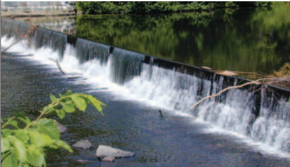
Figure 1. Lieu de la principale prise d'eau de la Ville de Québec à Loretteville
