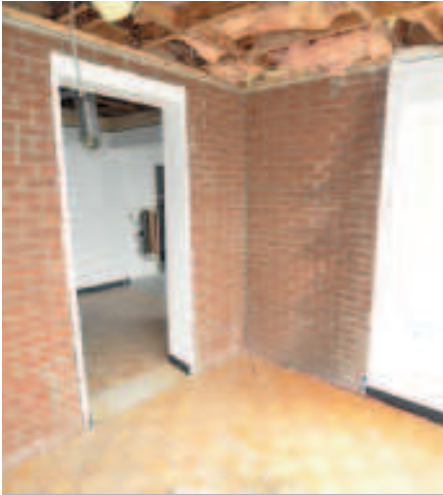
Le 2 e étage avant et après les travaux.
