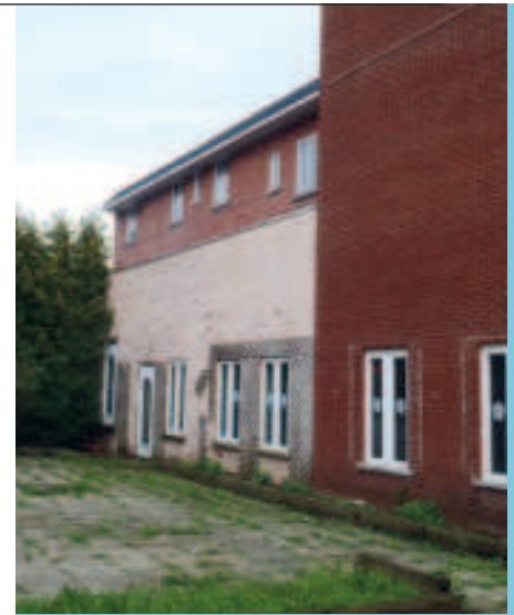
La terrasse avant et après les travaux.
