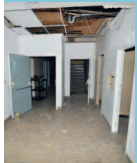
L'entrée avant et après les travaux.
