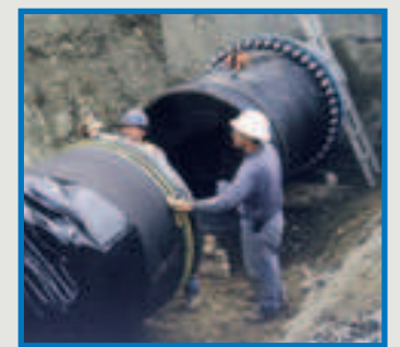
Conduite de 1 350 mm installée avec gaine de polyéthylène.
