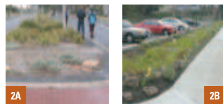
Figure 2. Exemples de fossés avec biofiltration.
