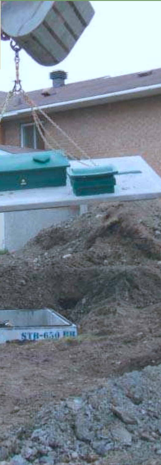
Figure 1.0 Installation typique du biofiltre et des équipements de mesure
