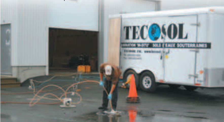
Application du traitement Soltec in-situ à l'aide de puits d'injection sous le bâtiment
