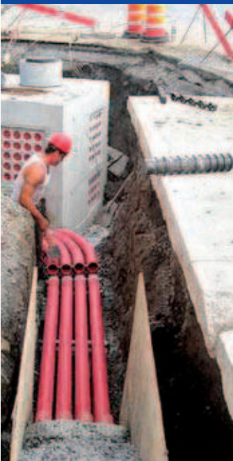
Installation de conduits
