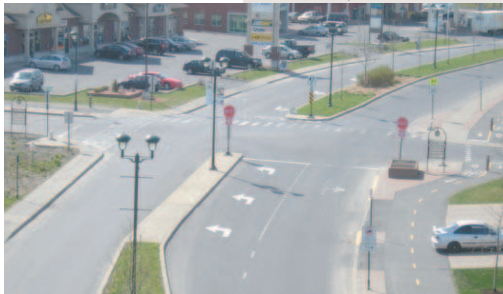
Fig. 2 Intersection du boulevard Jean-Leman et de la rue Dauphin
