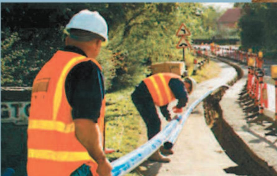
Tuyau à pression en PVC<sub>CO</sub> moléculairement amélioré pour applications souterraines d'adduction d'eau et d'égout sous pression
