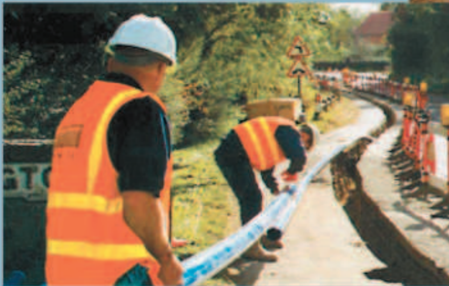
Tuyau à pression en PVCO moléculairement amélioré pour applications souterraines d'adduction d'eau et d'égout sous pression
