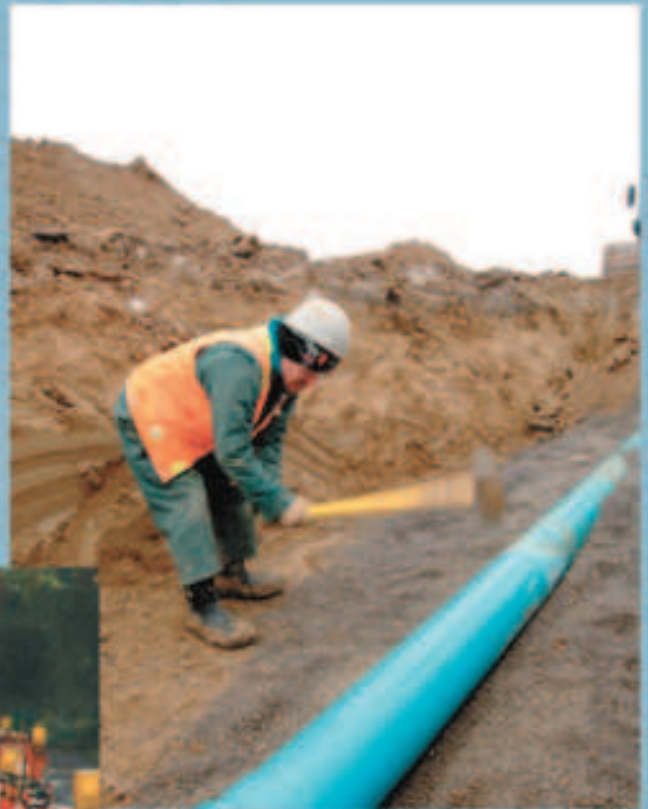
Tuyau à pression en PVCO moléculairement amélioré pour applications souterraines d'adduction d'eau et d'égout sous pression
