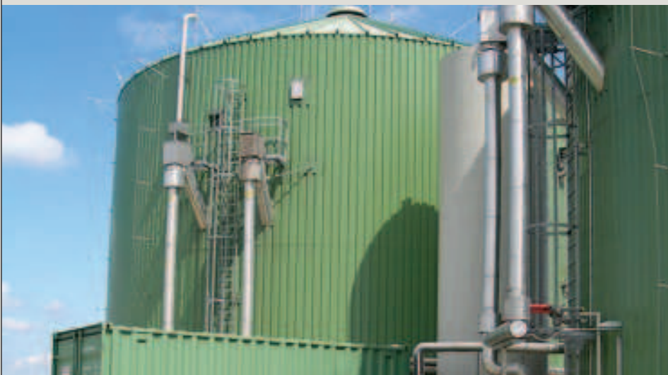
Installation de biométhanisation et production d'électricité, région de Vienne, 2008
