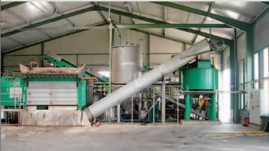
Installation de tri des matières organiques avant le biométhanisation. région de Vienne, 2008
