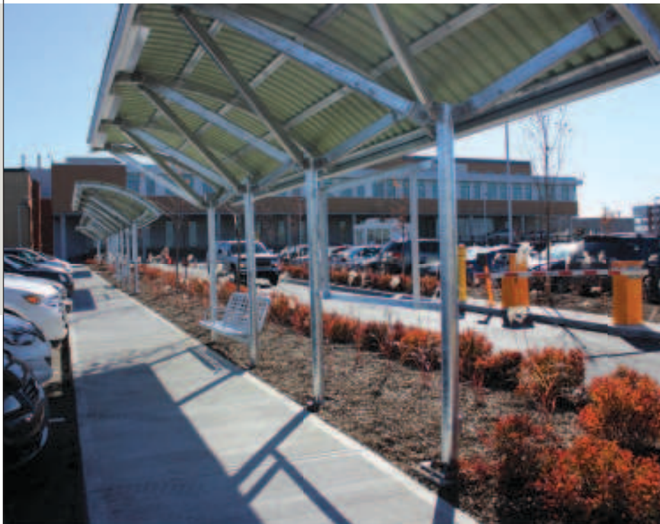
Un des trois corridors pour piétons et de ses abris (automne 2012). Chaque corridor comporte quatre abris, soit douze au total. Guérite d'accès à l'arrière-plan et bancs à l'avant-plan.
