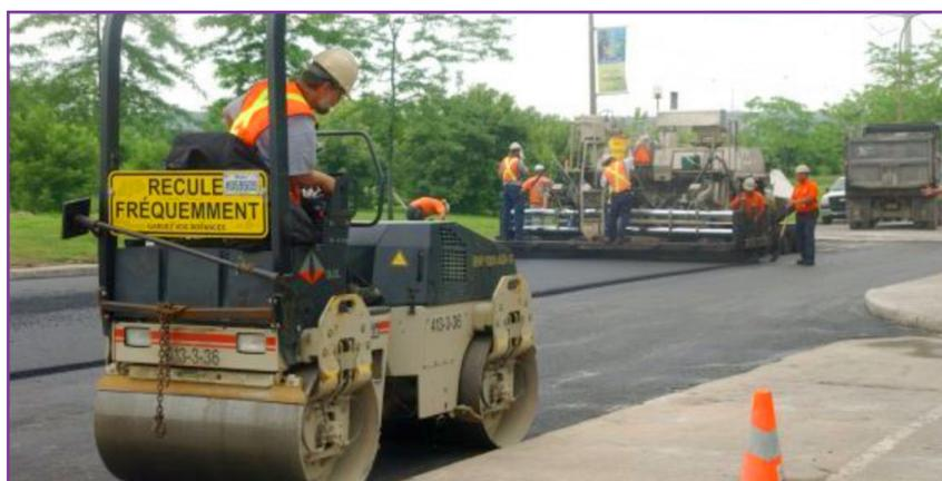
Figure 9 : Travaux de réhabilitation d'une chaussée
