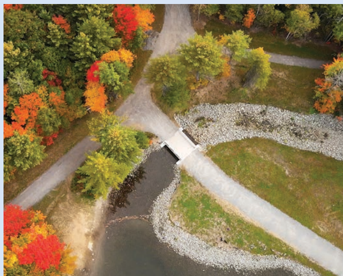
Mise aux normes du barrage du lac Jérôme
