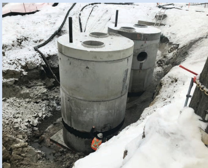
Reconstruction des rues Lavolette et des Cèdres
