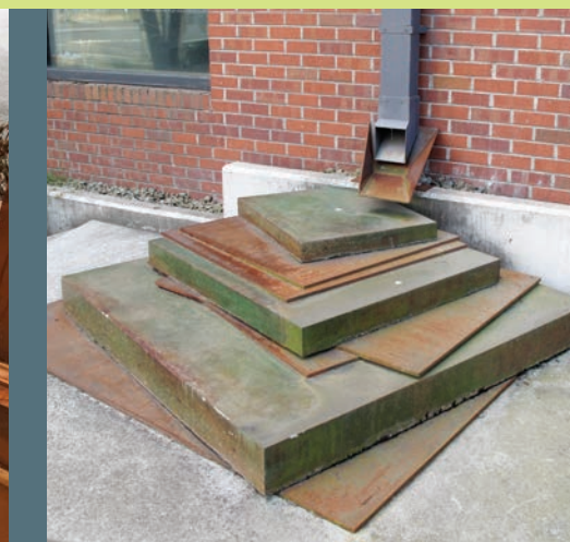
Évacuation de la gouttière de bâtiment pour donner impression de fontaine pendant une pluie © GRL
