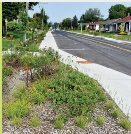
La rue Saint-Maurice après les travaux © GC Janson
