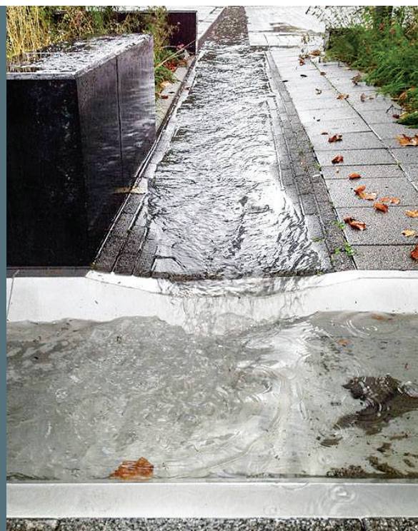
Caniveau de transport d'eau de pluie © Vancouver Public Spaces
