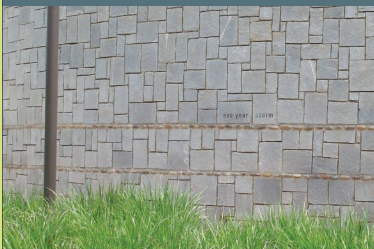
Lignes de démarcation des niveaux de service du bassin par l'insertion de pierres sur le mur © GRL
