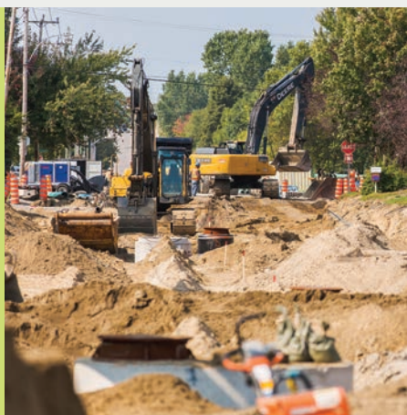
La rue Saint-Maurice pendant les travaux © B Ronde
