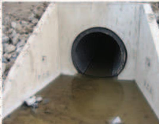
**Conduite triple paroi de 900 mm insérée**
