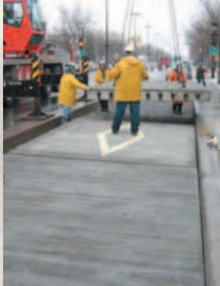
La prochaine étape consistait à injecter un coulis cimenteux sans retrait aux joints entre les dalles pour assurer l'ancrage entre celles-ci et également dans les canalisations sous les dalles afin d'assurer un appui uniforme des dalles sur toute la fondation.
