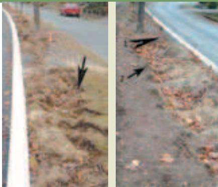
Blessures apparentes à la suite de l'abaissement du niveau du sol, causées par le charcutage des racines pour combler le vide entre la nouvelle bordure et le sol existant fourmillant de racines.
