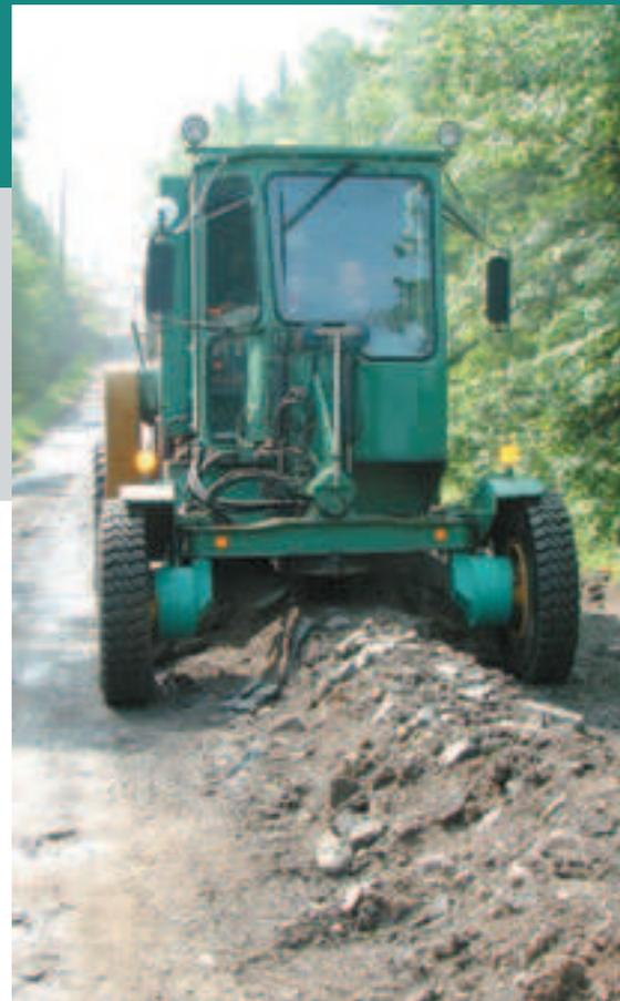
À titre démonstratif des travaux ont été effectués sur le Chemin Grande Ligne à la Ville de Racine au cours de l'automne 2009. Les travaux ont été réalisés sur un chemin pavé existant où la fondation granulaire en place avait une épaisseur variant entre 100 et 150 mm d'épaisseur. Le **tableau 1** présente les résultats d'analyses granulométriques avant la réalisation des travaux.
