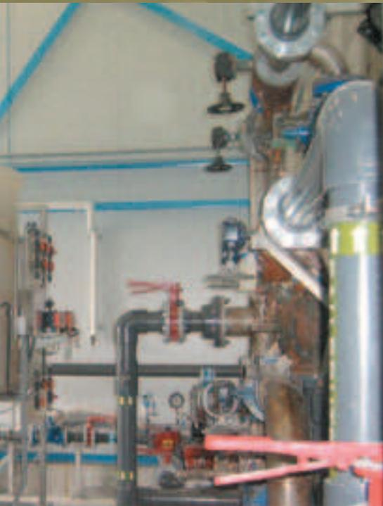
La transmittance de chaque puits a été évaluée, à 62,5 %, 84,3 % et 71 % pour les puits n° 1 à n° 3, respectivement. Ces résultats étant faibles, spécialement pour le puits n° 1 (puits le plus productif), le système ultraviolet perdait entièrement son efficacité. La présence de couleur dans l'eau constitue une interférence.
