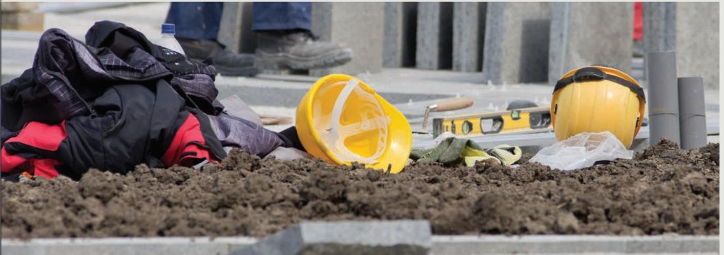
Parmi les principaux risques reliés aux travaux de creusement, d'excavation et de tranchée, on retrouve des dangers d'ensevelissement, de manutention mécanique, de heurt par un véhicule, d'électrocution, etc. Il est donc important de se protéger et d'adopter les bonnes mesures de prévention.
