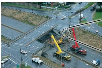
**Figure 1 a :** Effondrement du viaduc de La Concorde (Johnson et coll., 2007)
