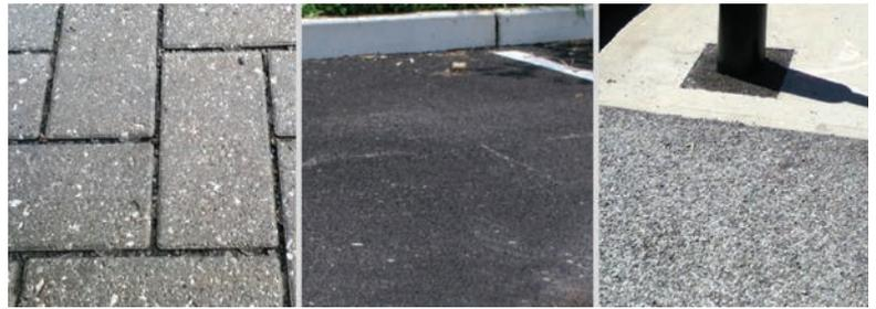
**Figure 1 : Exemples de revêtement perméable.
