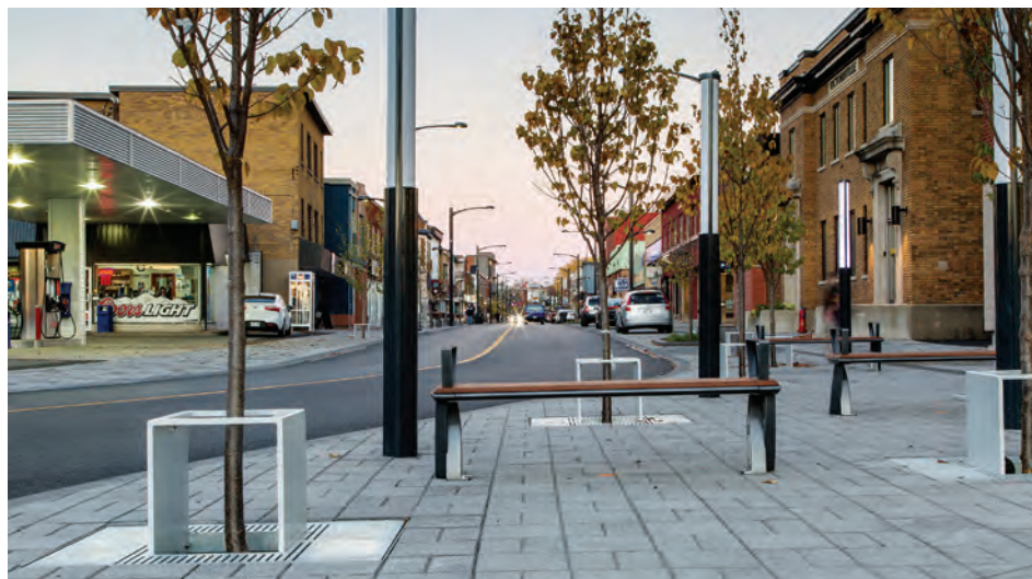
Vue de la rue Notre-Dame après les travaux de la phase 1.
