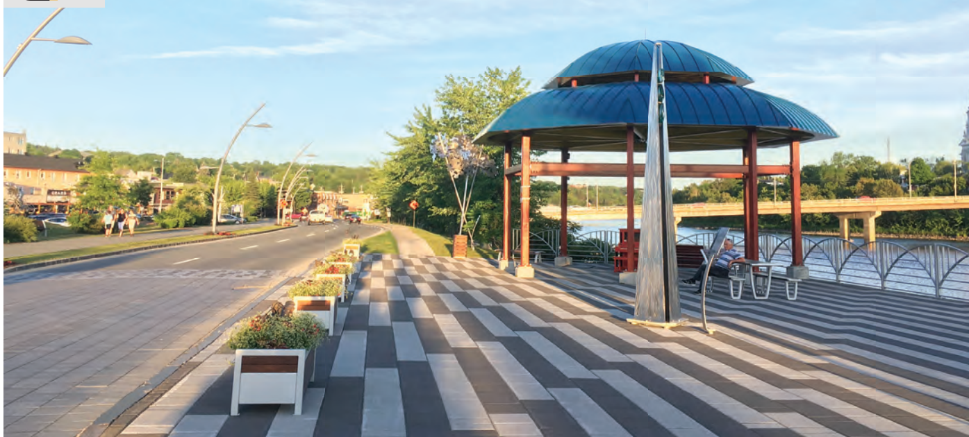
Première phase des travaux de revitalisation à Saint-Georges-de-Beauce © Pier-Olivier Morissette
