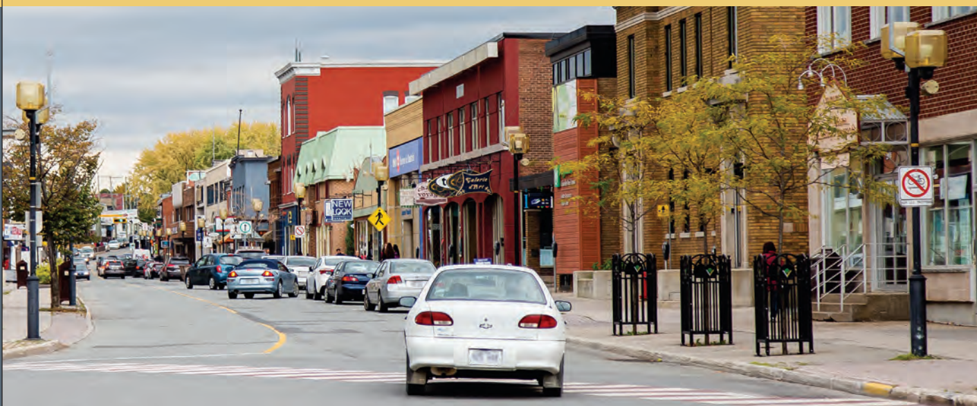
Vue de la rue Notre-Dame avant les travaux.
