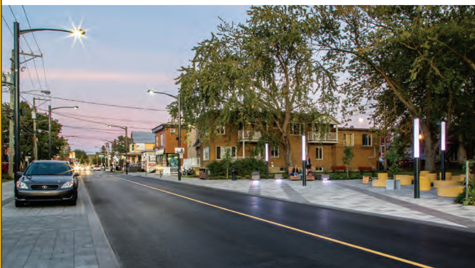
Vue de la rue Notre-Dame après les travaux de la phase 2.
