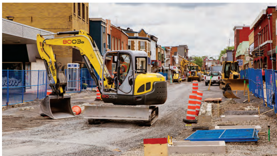
Vue de la rue Notre-Dame pendant les travaux de la phase 1.
