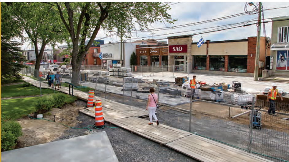
Vue de la rue Notre-Dame pendant les travaux de la phase 2.
