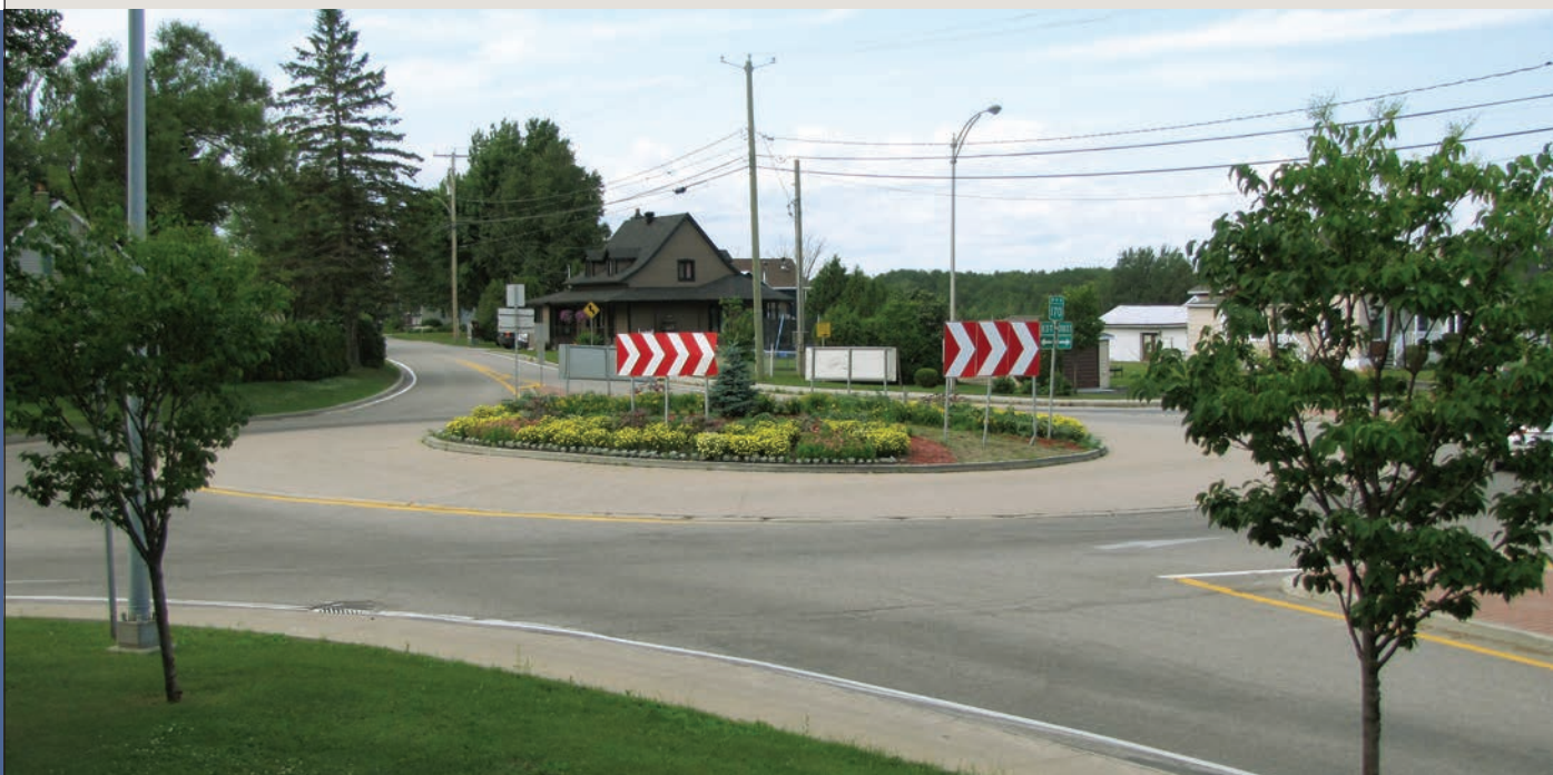
Photo 3. Les carrefours giratoires sont de plus en plus utilisés comme solution aux intersections.
