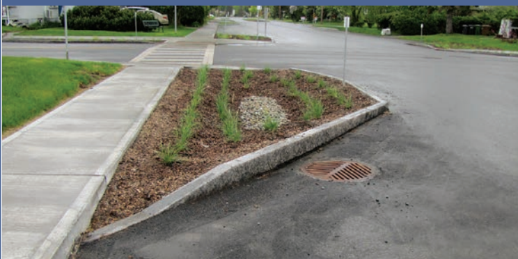
Photo 1. Zone de captation et d'infiltration des eaux de ruissellement.
