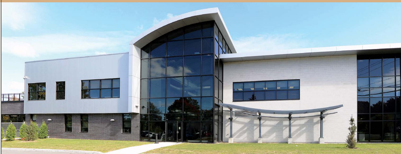
La station de purification de l'eau de Repentigny
