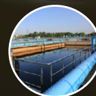
Réservoir de traitement des eaux usées
