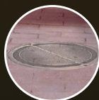
Refolement de conduite d'égout sous pression
