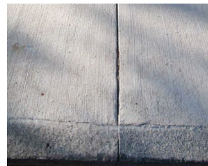
Photo 3 - Joint de retrait par truelle, sans épaulements © Ruesécure
