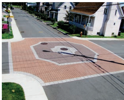
Photo 2 - Intersection surélevée. © Ruesécure
