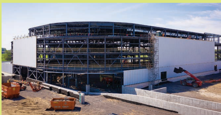
Nouveau colisée Vidéotron - Avancement des travaux au 10 juin 2019
