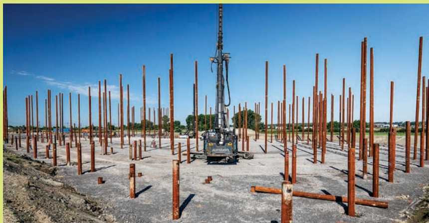
Nouveau colisée Vidéotron - Avancement des travaux au 12 septembre 2018
